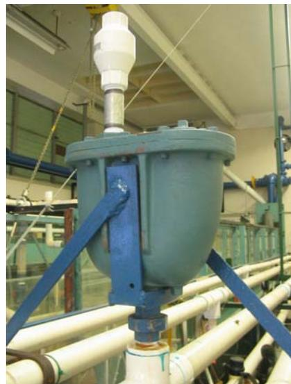
**Figura 36. Válvula de admisión de aire – Air inlet.**
