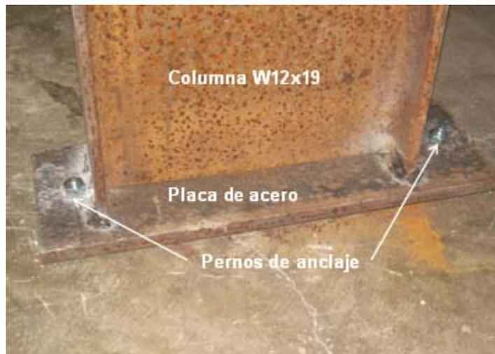
**Figura 5-6 Sistema de anclaje columna-piso**
