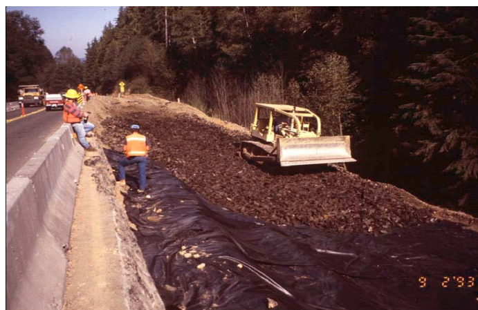
Figura 3- 18 Construcción de relleno de bajo peso con neumático triturado, carretera US 101 (Foto de Baker y otros, 2003)
