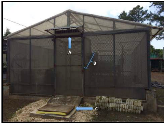
Figura 2. Estructura protegida (a) Cortina de aire. (b) Doble puerta. (c) Recipiente con solución desinfectante (Hipoclorito de Sodio al 10%)
