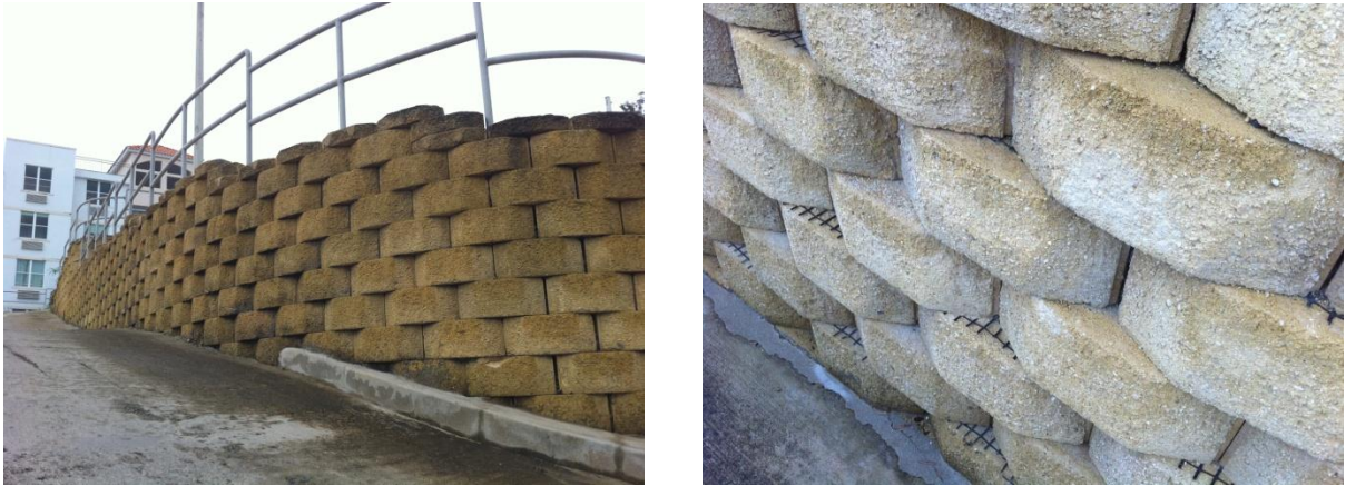
Figura 4.5 Fotografías de muros mecánicamente estabilizados reforzados con geomallas
