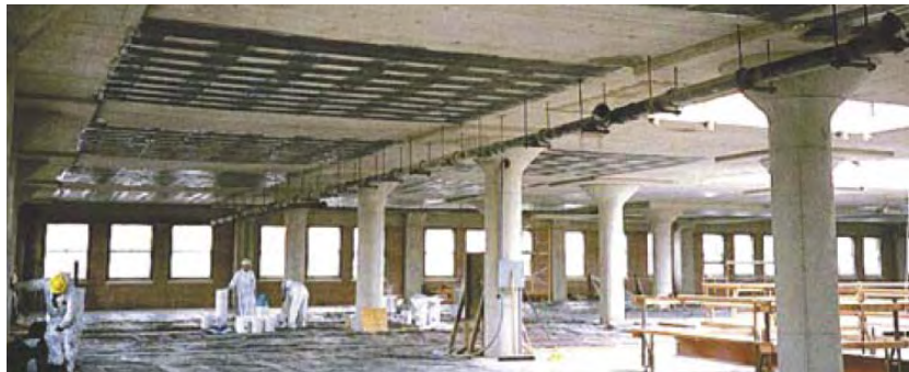
c) Reforzamiento de placas (Fyfe Co. LLC, pag. web, 2006).
