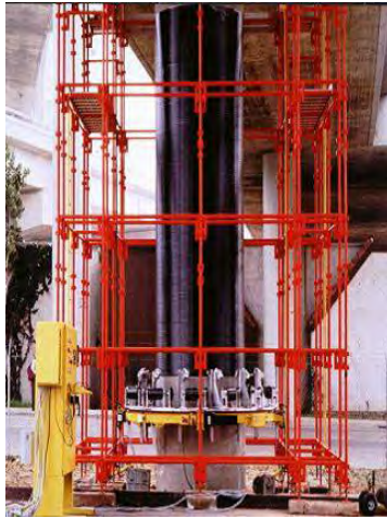
a) Reforzamiento de columnas (FHWA, pag. web, 2006).
