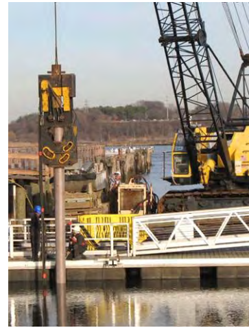
b) Pilotes compuestos (Pearson Pilings, pag. web, 2006)
