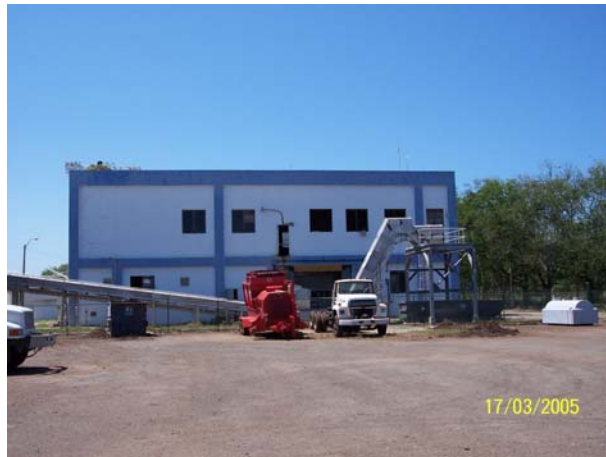
Figura 4- Área de descarga de material proveniente de cieno sanitario
