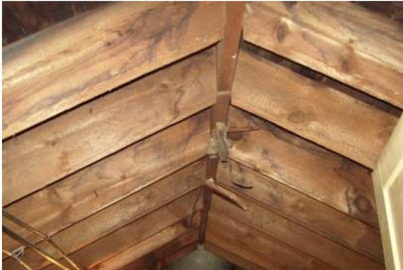
**Foto 21. Viguetas de madera que forman el techo en una parte del edificio**
