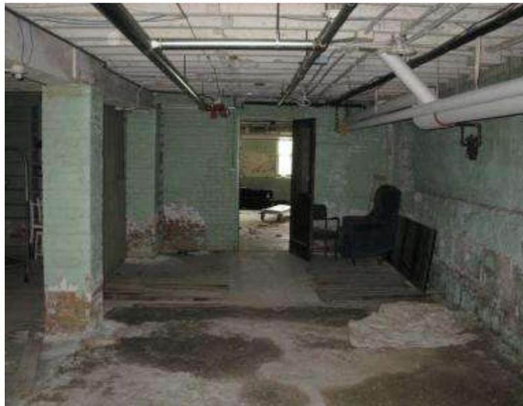
**Foto 8. Diferencia en materiales que componen el piso del sótano: parte en Madera y parte en Concreto**
