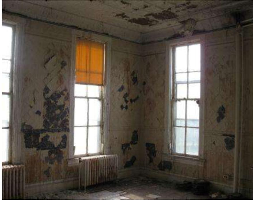
Foto 17. Interior de cuarto de oficina donde se notan los paneles y papeles decorativos en el techo y las paredes y las losetas sobre la madera del piso
