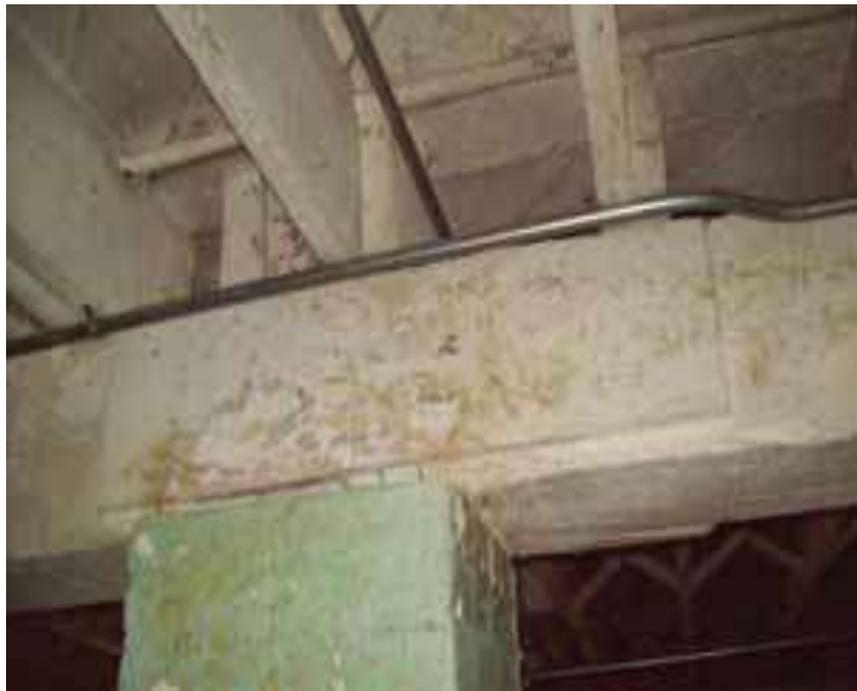
Foto 15. Uniones entre viga de madera y columna de ladrillo y viguetas de madera sobre viga
