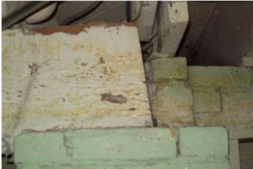
**Foto 13. Unión entre vigueta de madera sobre pared de ladrillo**
