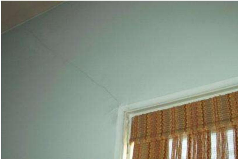
**Foto 19. Grieta partiendo desde la esquina de una ventana hacia el techo en forma diagonal**
