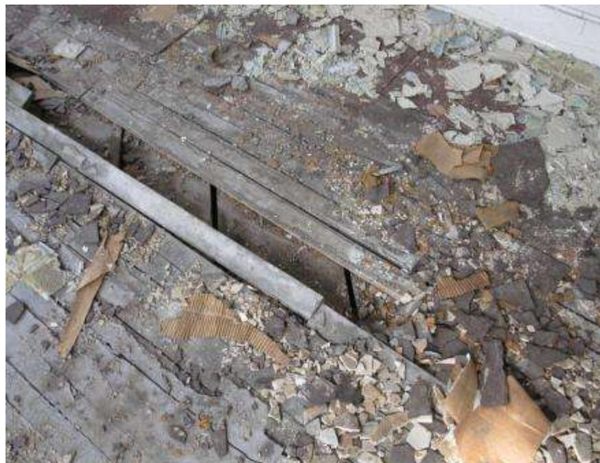
Foto 18. Sub-piso de paneles de madera de arce puestos en forma diagonal y piso de madera con paneles tipo 'lengüeta y surco' ('tongue & groove')
