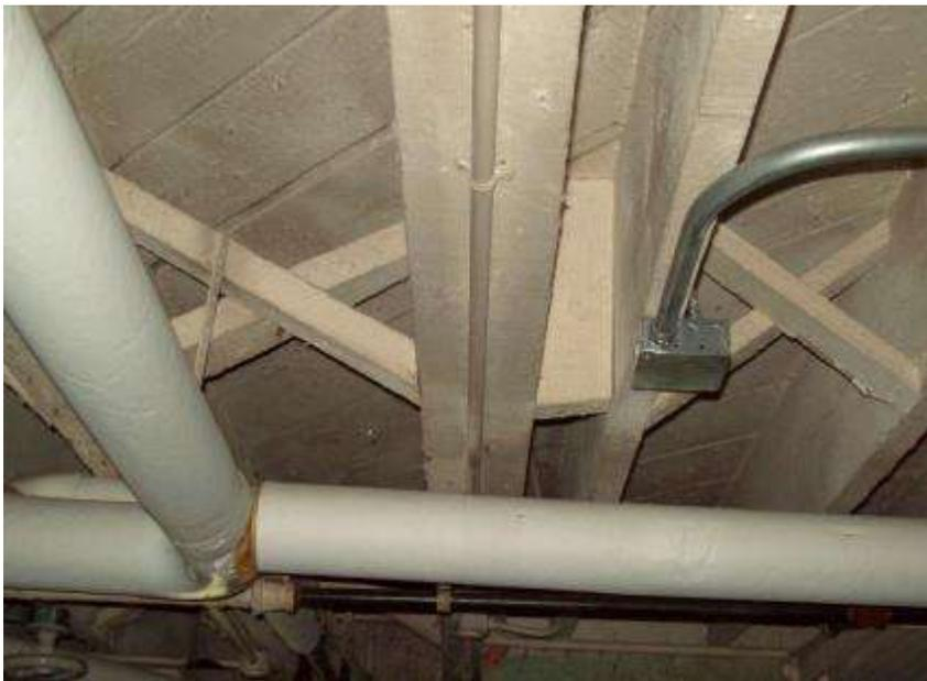
Foto 29. Brecinas o "bridging" entre viguetas de madera para aumentar resistencia entre largos de viguetas mayores de 8 pies
