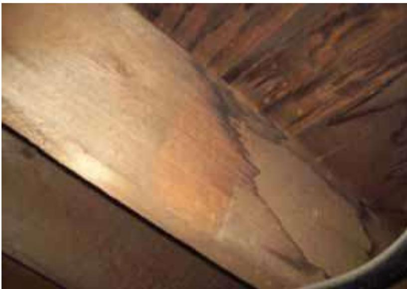
**Foto 22. Viguetas con marcas de filtración de agua por el techo**
