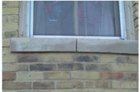
**A. 8. Mejoras en los ladrillos exteriores con mortero y grieta en marco de concreto de ventana**
