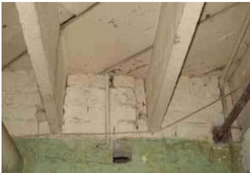
**Foto 14. Uniones entre viguetas de madera y fundación de mampostería**
