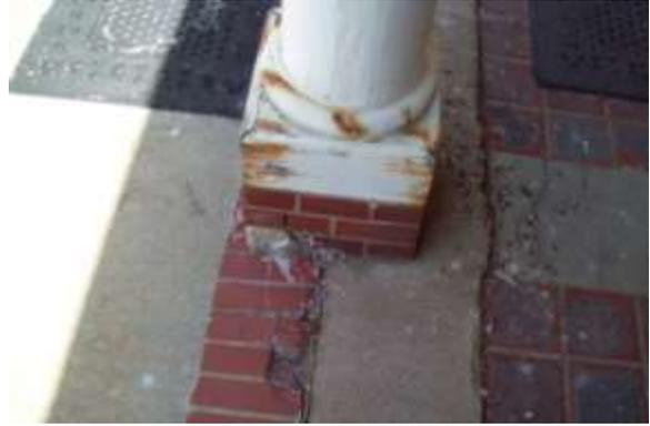
**A. 6. Detalle de deterioro de columna de Madera del balcón**
