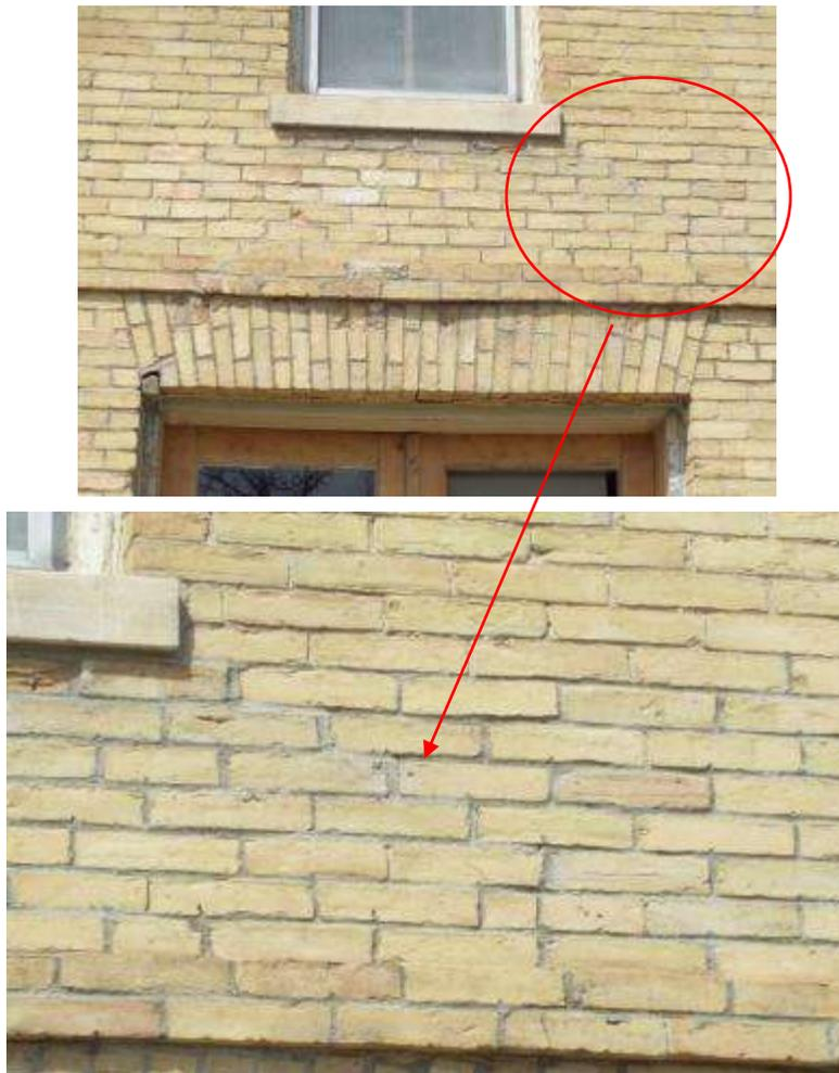
Foto 26. Reparación de grieta diagonal desde esquina de ventana en el exterior
