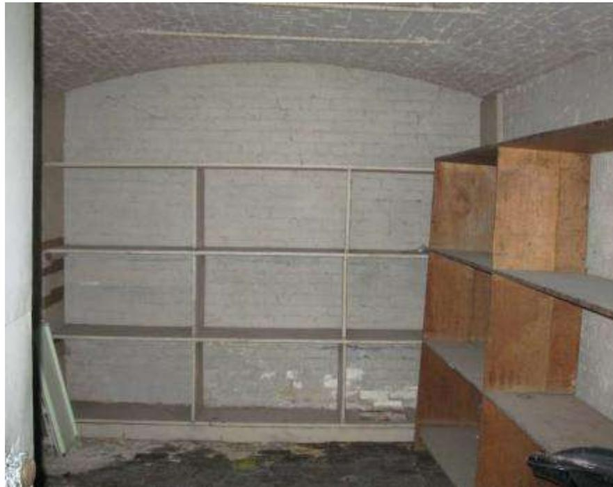
Foto 10. Interior de una de las Bóvedas en el sótano hecha con paredes y techo de ladrillo
