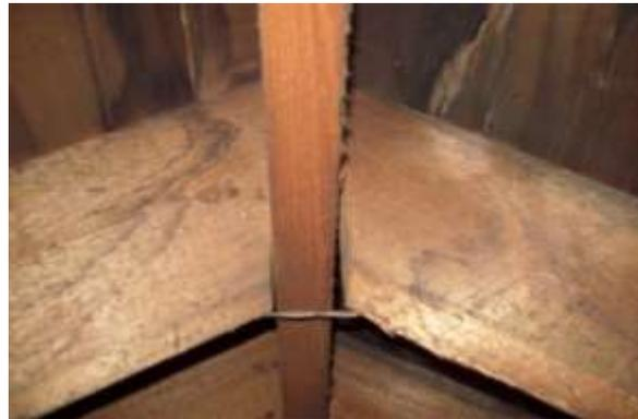
**A. 7. Grieta desde esquina de puerta y detalle de falta de anclaje suficiente entre viguetas diagonales del techo**
