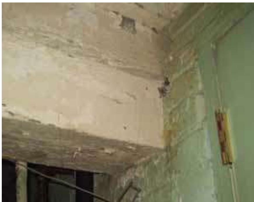
Foto 16. Unión entre viga de madera y pared de ladrillo
