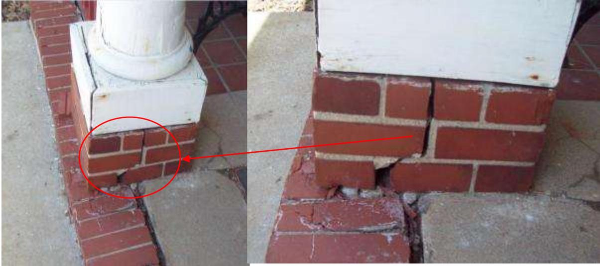
Foto 27. Grieta en base de ladrillo que soporta una de las columnas de madera que forma el pórtico del balcón de entrada
