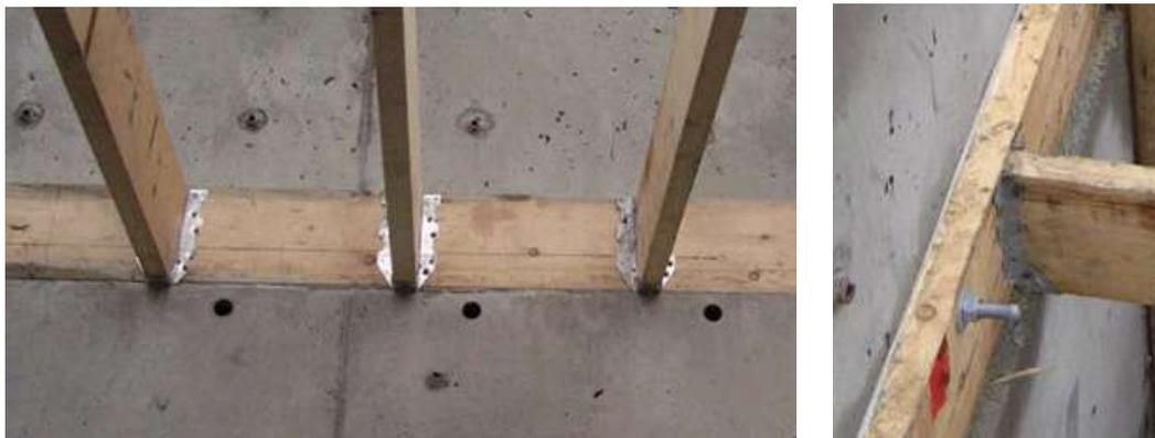
Figura 7. Detalle de posible conexión entre viguetas de madera y revestimiento con paredes de concreto reforzado
