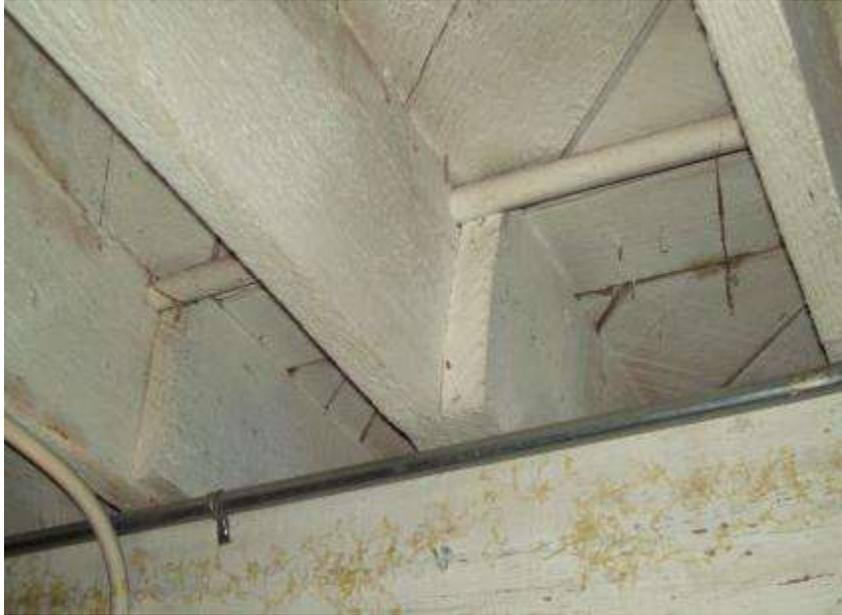
Foto 28. Marco interior creado con viguetas y vigas de Madera de Roble y sub-pisos de Madera de Arce
