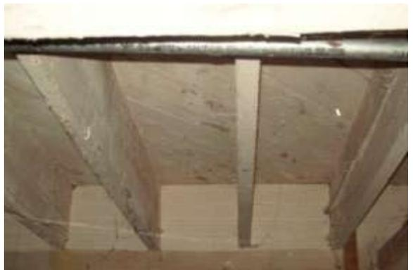
A. 4. Elementos estructurales del piso 1 incluyendo misceláneos, viguetas y piso de madera
