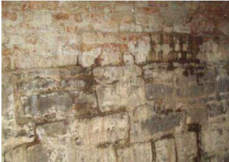
**Foto 7. Evidencia del filtración de agua en una pared del sótano**
