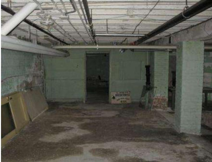
Foto 9. Evidencia de filtración de agua en piso de concreto del sótano
