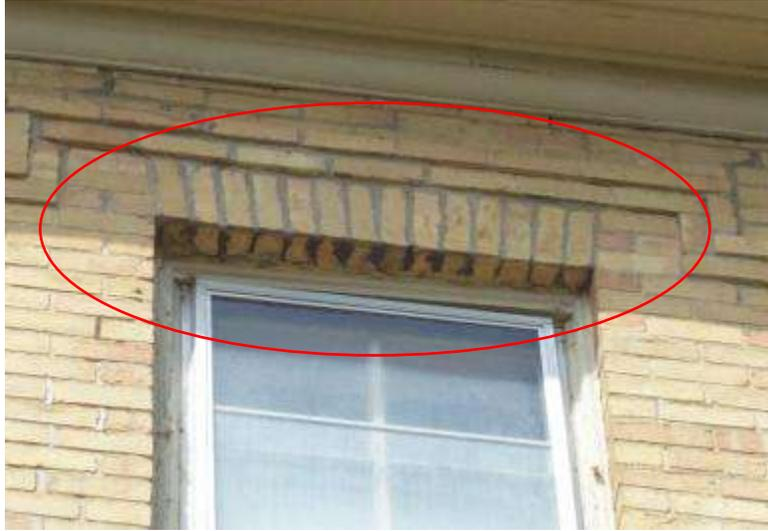
Foto 25. Detalles en ladrillos reparados con mortero
