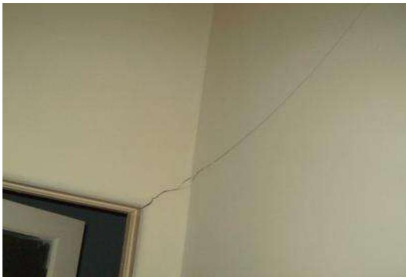
**Foto 20. Grieta partiendo desde la esquina de una puerta hacia el techo en forma diagonal**
