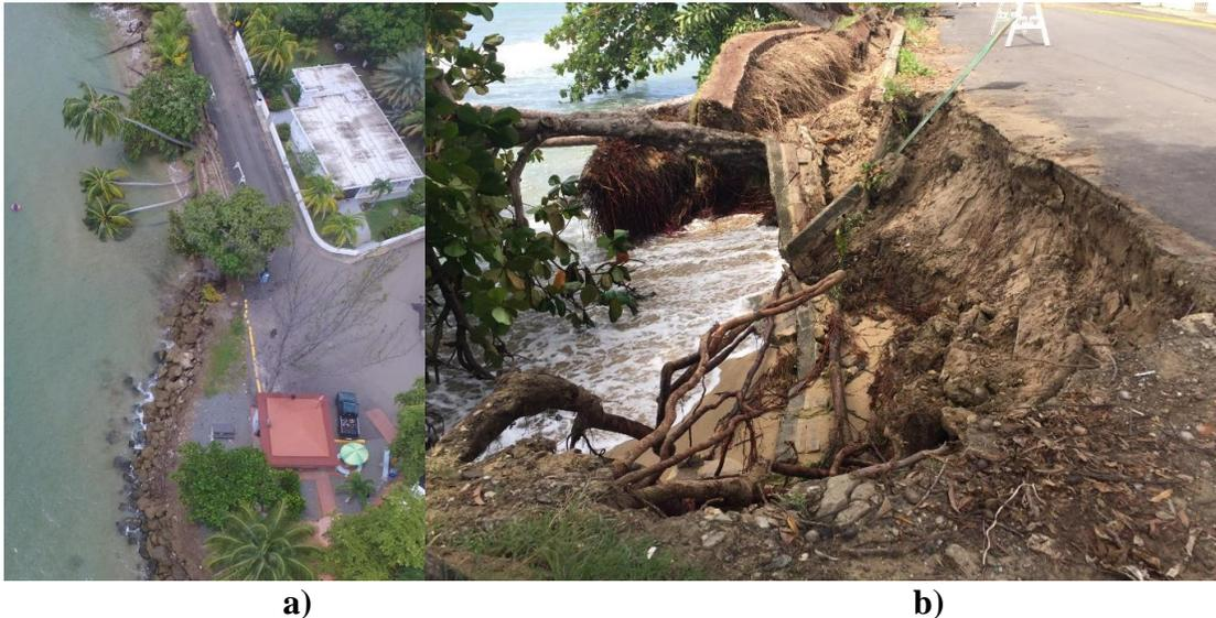
Figura 8: Zona impactada por la marejada en la playa de Stella, Rincón, Puerto Rico: a) vista aérea de la erosión del asfalto, b) vista terrestre de la erosión en Stella (tomadas el 7 de octubre de 2016).
