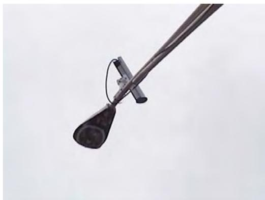
**Figura VI-3** Cámara instalada en Poste.
